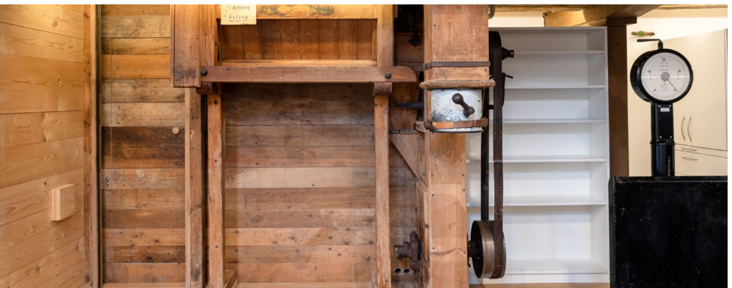
die noch vorhandenen Strukturen der alten Mühle konnten freigehalten werden
